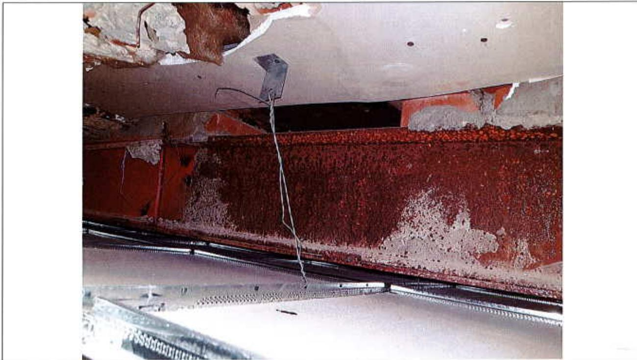
Non è stato possibile osservare direttamente il solaio, in quanto ricoperto da una prima controsoffittatura in pannelli di cartongesso, ai quali è appesa una seconda controsoffittatura. Ulteriori informazioni, relative alle travi in acciaio, sono riportate in allegato nel Rapporto di prova delle indagini pac-ohmetriche.
