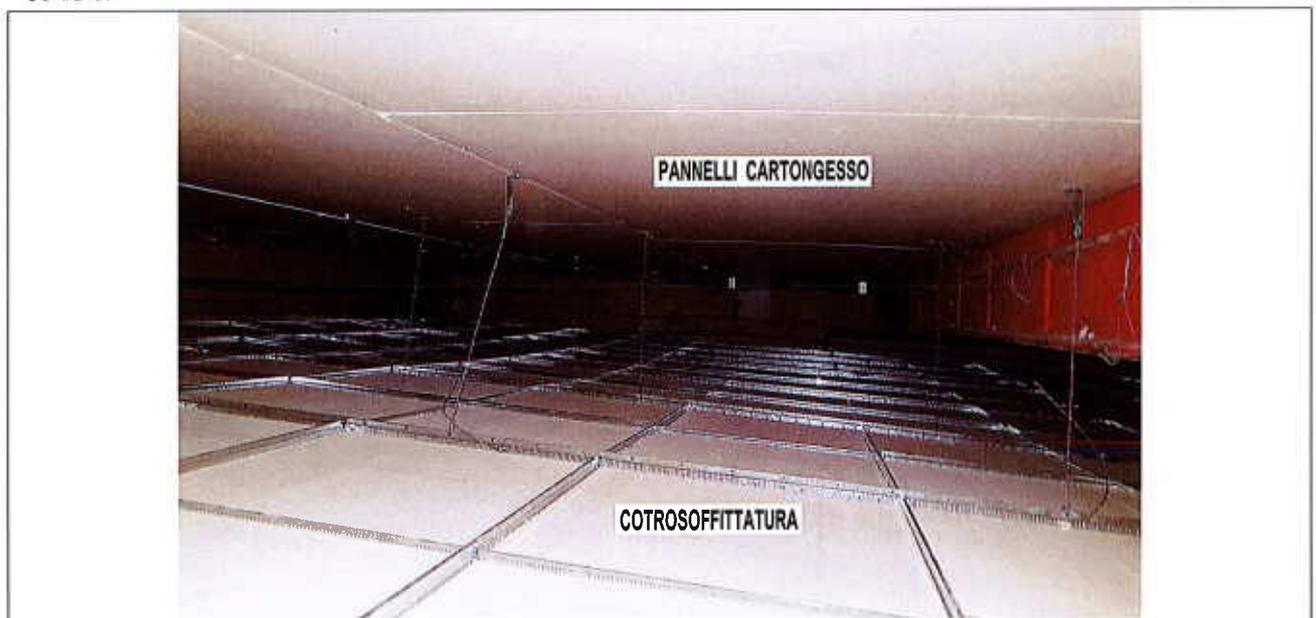
Non è stato possibile osservare direttamente il solaio, in quanto ricoperto da una prima controsoffittatura in pannelli di cartongesso, ai quali è appesa una seconda controsoffittatura. Ulteriori informazioni, relative alle travi in acciaio, sono riportate in allegato nel Rapporto di prova delle indagini pac-ohmetriche.
