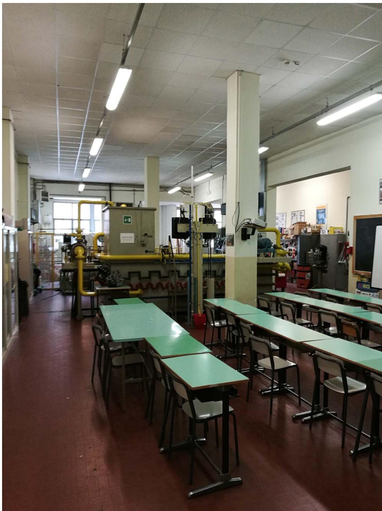
Interni del blocco C al piano terra
