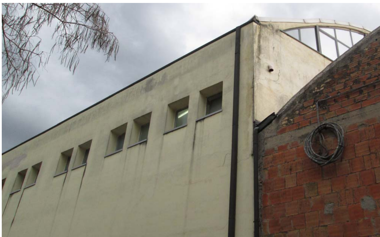
Facciata nord del blocco C
