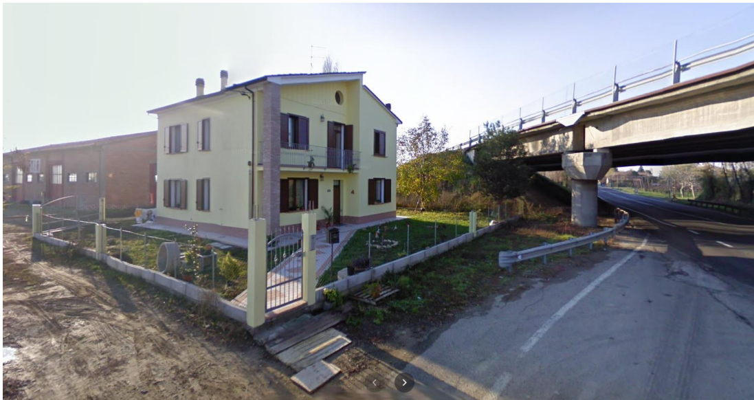
Figura 3: Vista ravvicinata edificio e viadotto autostradale.
