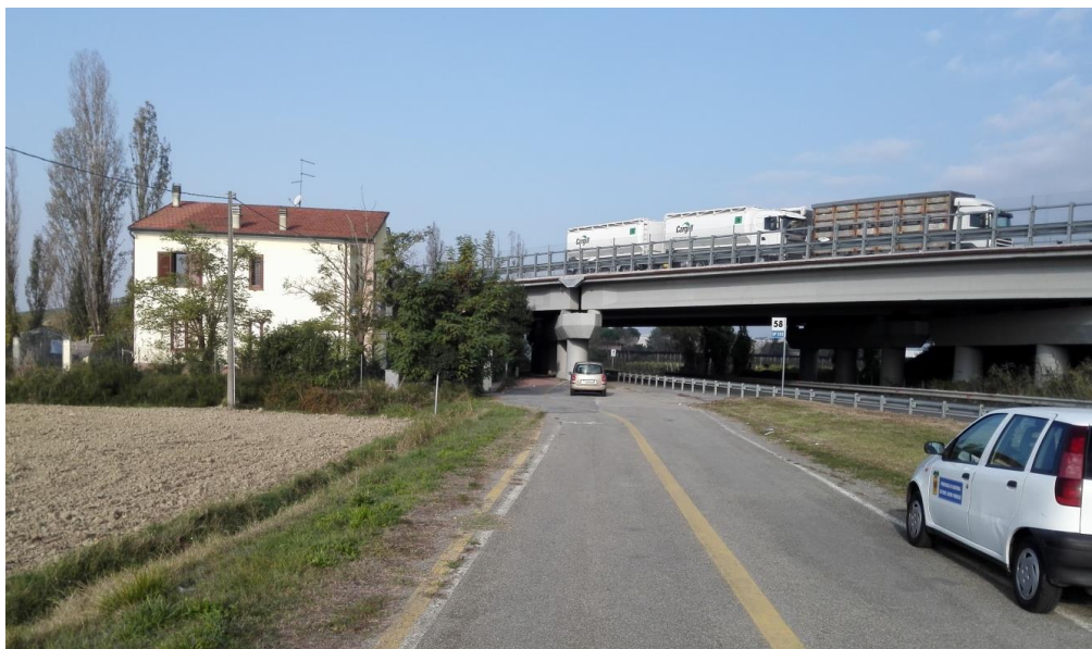
Figura 2: Vista edificio e viadotto autostradale da via Vecchia Albergone.
