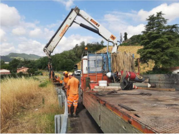
Smontaggio lame per riposizionamento
