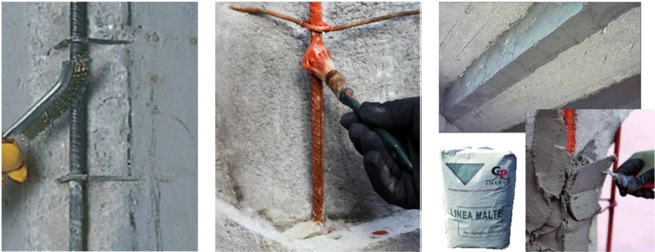
Fig. 6 - Spazzolatura, passivazione e ricostruzione
