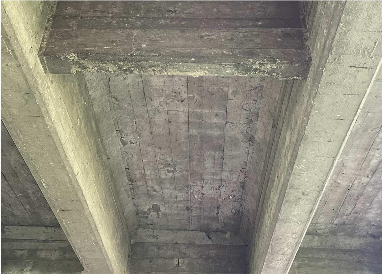
*Foto 9 - Ripristino corticale - Travi interne della pila lato Bagnacavallo*
