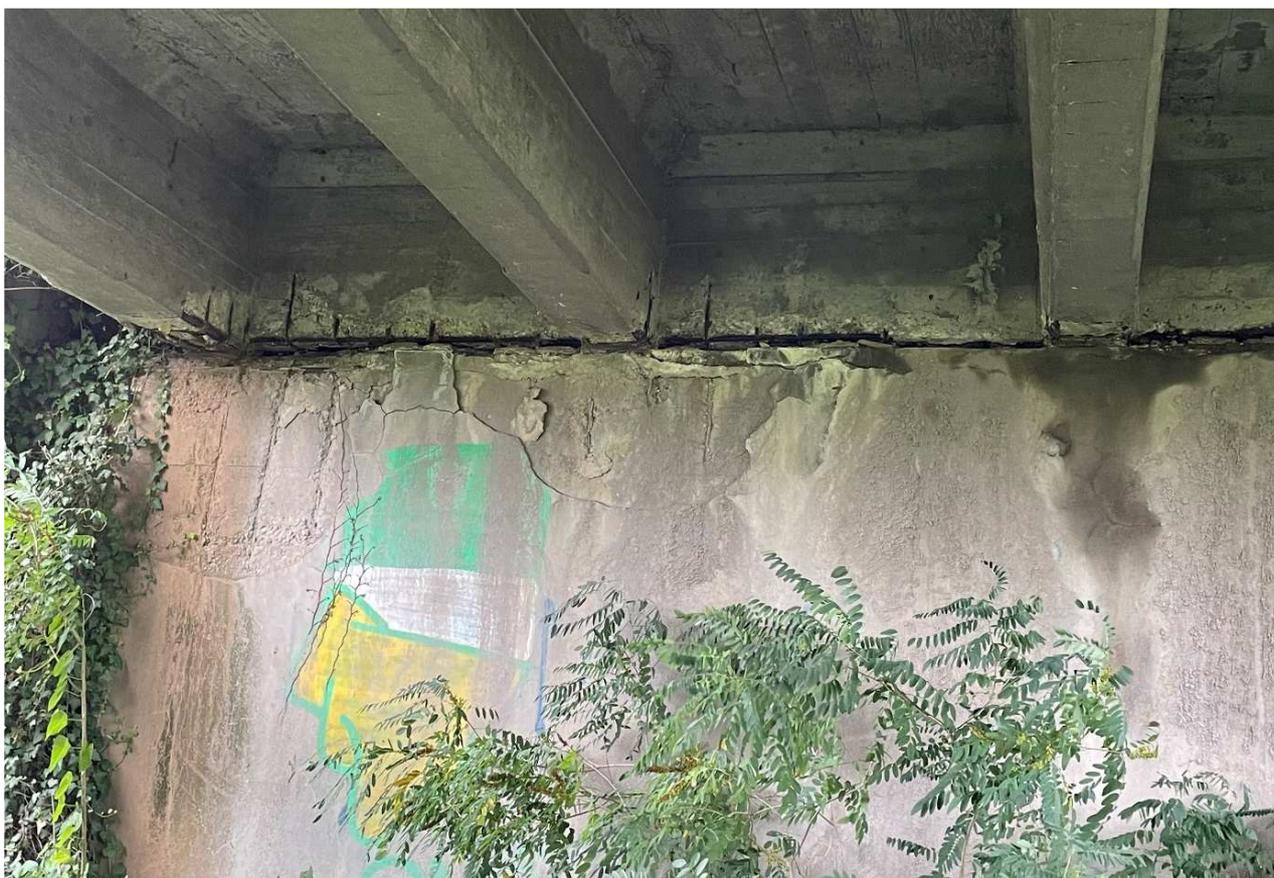
*Foto 6 - Ripristino strutturale - Appoggio travi nella spalla lato Bagnacavallo*
