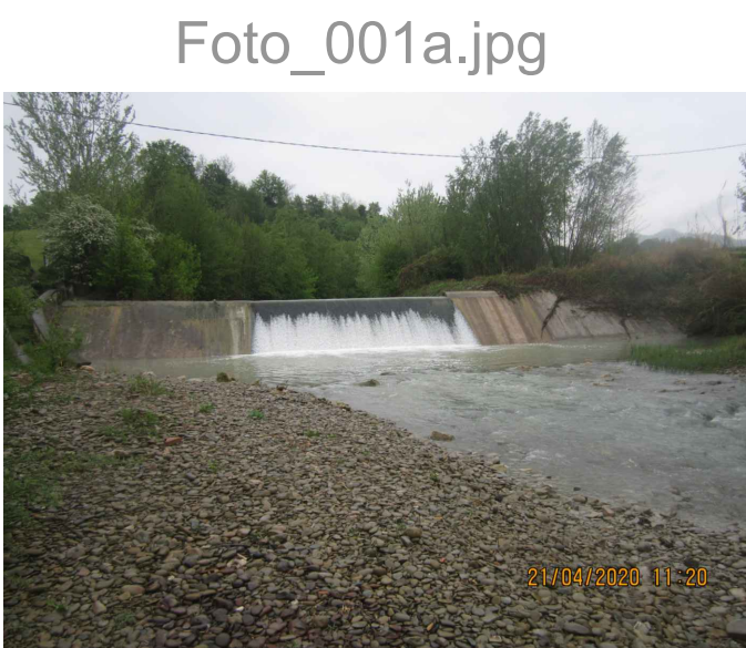
Foto della chiusa in data 21-04-2020
