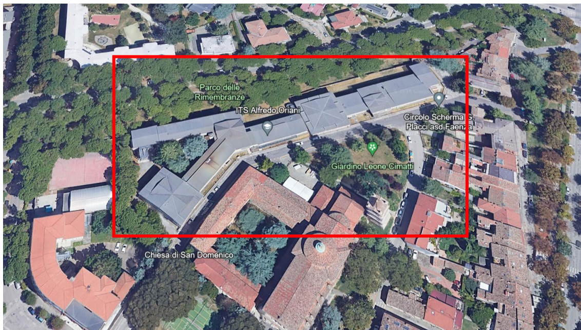
Inquadramento dell'edificio nel contesto
