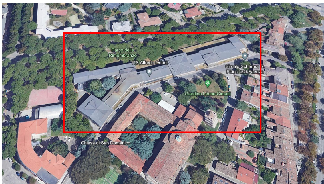
Inquadramento dell'edificio nel contesto
