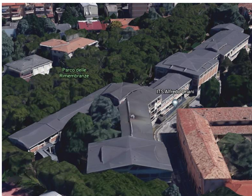
Figura 2.1-1 Vista dell'edificio dall'alto
