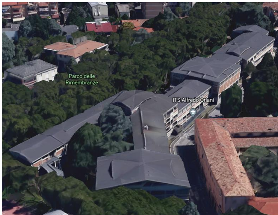
Figura 2.1-1 Vista dell'edificio dall'alto
