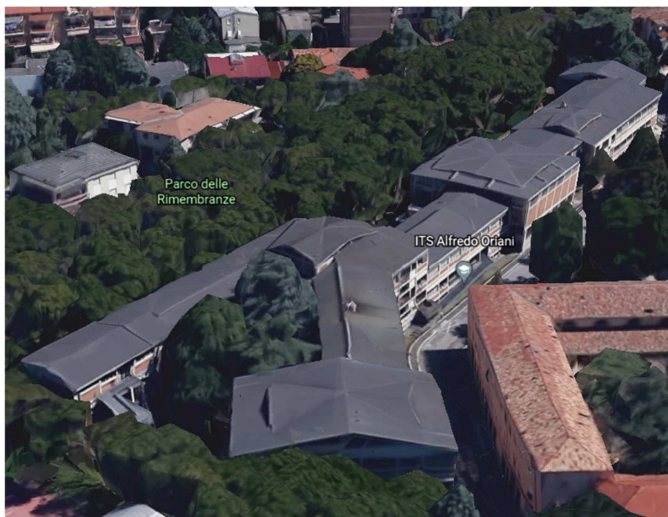
Vista aerea dell'edificio
